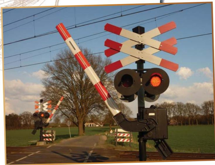
В наше время шлагбаумы уже не поднимают вручную — они стали автоматическими. А чтобы сделать железнодорожный переезд ещё безопаснее, кроме шлагбаума, на нём устанавливают светофор, часто оснащённый звуковым сигналом, и даже специальные устройства в виде металлических плит, которые поднимаются и загораживают проезд.
